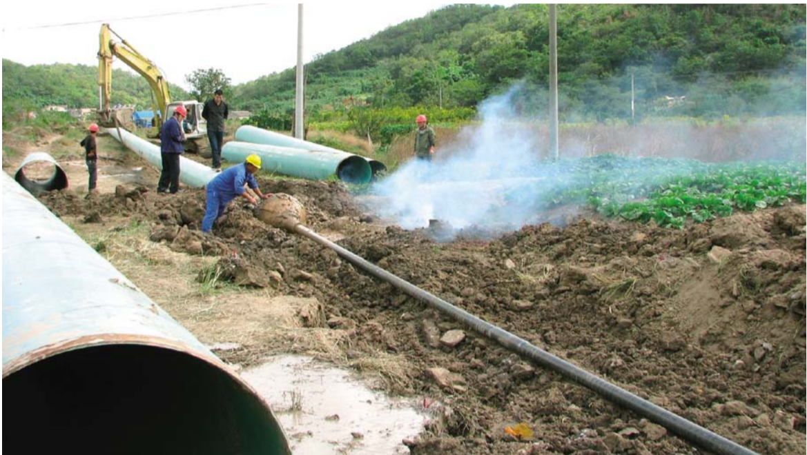
图为普陀区本岛饮用水安全二期工程供水管拖拉穿越敷设场景。
