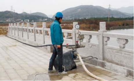
沈家门勾山DN1000供水管的全线贯通为整个普陀饮用水安全二期工程后续部分管线的顺利敷设奠定了基础。
