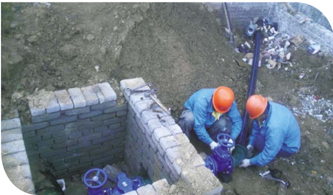
(图为昌通公司施工人员正在对阀门井、水表井等附属进行安装施工。)
