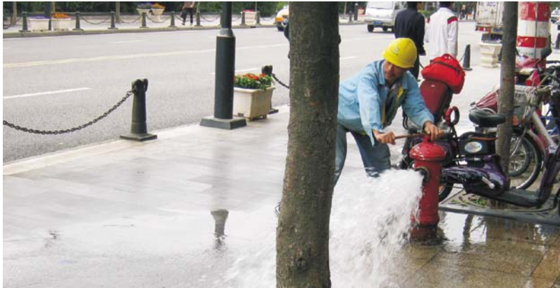
(图为维修人员正在对环城东路的一处消防栓进行检修)
