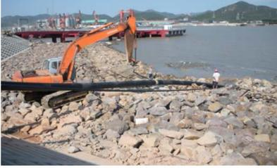
图为施工工人正在外钓岛海域实施 DN450PE 供水管穿越拖拉敷设
