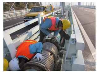
12月22日上 午, 舟山跨海大桥 桃夭门大桥钢桥上 活跃着一群特殊的 施工队,他们是岑 港营业所管道维修 人员, 在分管领导 邵善康的带领下正 进行一场特殊而紧 张的工作——更换 DN400MM 复式波 纹补偿器
