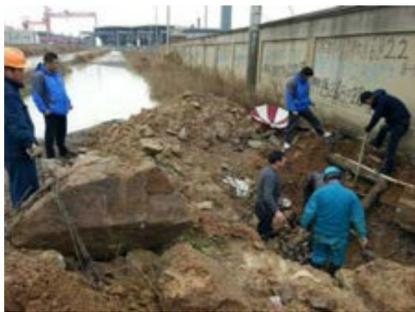
3月5日是一个雨雪交加的元宵节。上午9时，岑港营业所接报，位于定海工业园区区长宏国际附近水管爆裂。险情就是命令，该所立即组织抢修队伍和抢修车赶赴现场。经现场查勘，开挖后发现直径200毫米的PE管因热胀冷缩弯头脱焊断裂移位，导致漏水，营业所采用接管热熔焊接进行紧急抢修，于当天下午13时及时恢复供水。
