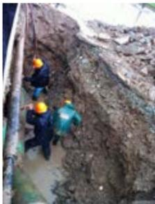
2015年3月5日中午雨雪交加，临城万二村村头DN400钢管出现接点渗漏险情，临城营业所管线维修部组织应急抢修队紧急抢修。
