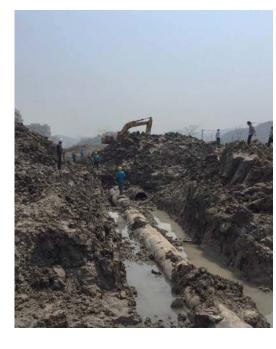
3月31日晚7时,普陀营业所承诺维 修处值班人员发现,管网监测系统显示城 区水压瞬间降低,于是立刻上报于公司调 度中心,经分析,疑为大口径管道爆管。 随后, 营业部立刻组织全体人员分别前往 勾山、东港、普陀城区等区域进行检漏排查, 并于晚上8时确定为勾山陆港物流西南侧 DN800 管爆管。
