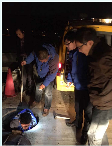
图为营业所值守人员抢修关停阀门井
