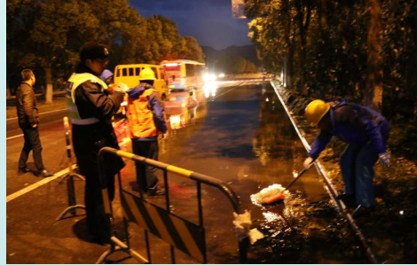
图为抢修寒潮冰雪天被撞断的消防栓
