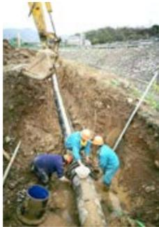
3月19日，随着最后一段DN400钢管的成功接点，岑港富翅岛DN400球墨管道改道工程顺利竣工。
