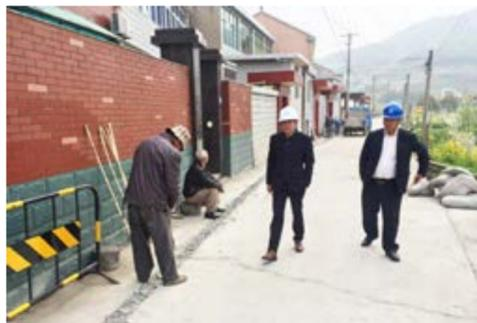
为了解决金塘沥港区域供水水压不足、黄水等问题，金塘分公司将逐步对该区域供水管网进行改造。近日，经金塘分公司精心组织，沥港鞍山南路一带给水管道改造工程已经起步，涉及用户约100户，鞍山南路原先供水管网缺乏科学规划，布局不合理，且供水的管材相当部分为水泥管和镀锌钢管，自来水管网设施较陈旧，供水区域水压不均衡、漏耗大、淤塞严重。该区域将主要安装DN100以下PE管1100米，改造后的供水管网水量、水压将明显改善，促进自来水的利用率，且将原先墙上的水表移到地下，能有效降低寒潮时水表被冰碎的风险，减少漏失水量，提高供水的安全性。（贺争杰）
