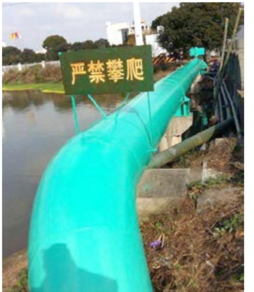
为延长供水桥管使用年限，确保供水安全，自2016年下半年起，普陀营业所对管辖区域内的供水桥管进行了一次集中油漆防腐工作。截止2017年3月底，该工程已全部完工。
