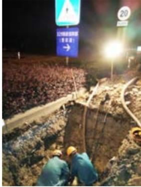
下午14时，抢修开始。到达抢修现场，抢修人员各司其职，有序施工。现场勘察后发现，此次抢修需克服几方面困难：一是施工地段管道埋设较深，挖掘机挖掘时需格外小心，如不慎再将管道挖破，后果不堪设想；二是施工段地基下有诸多块石，需采取电镐和人工开挖方式进行；三是暴雨即将来临，爆管后的自来水不断向外渗出，如在暴雨来临前，靠简单塘渣回填、面层表面石粉回填等处理，暴雨会冲刷掉回填路面的塘渣和石粉，容易造成抢修基坑的塌方，对道路交通安全形成隐患。经研究，施工员们果断决定在基坑回填后，暂用2米\*3米的钢板盖在基坑上方，避免暴雨冲刷，又能极大地减少过往车辆对基坑的二次碾压产生安全隐患。20时40分，200PE管抢修断面成功挖出；经过半个小时的努力，成功将哈夫抢修节抱箍于漏点处，开启阀门。确保无漏点后，将2米\*3米的钢板盖在了道路上，抢修结束，回填完毕。路障、警示牌、标识线等全部拆除，抢修人员和车辆撤离，道路恢复通畅，市区恢复正常供水。
