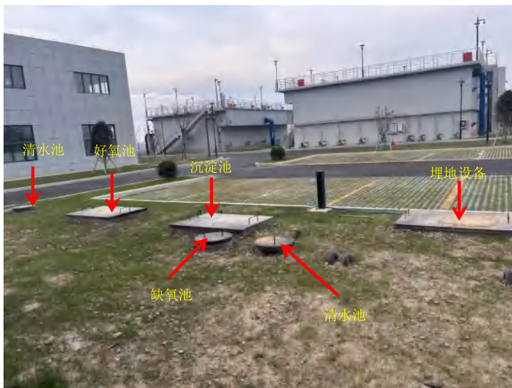
图 3-6 一体化污水处理设施
